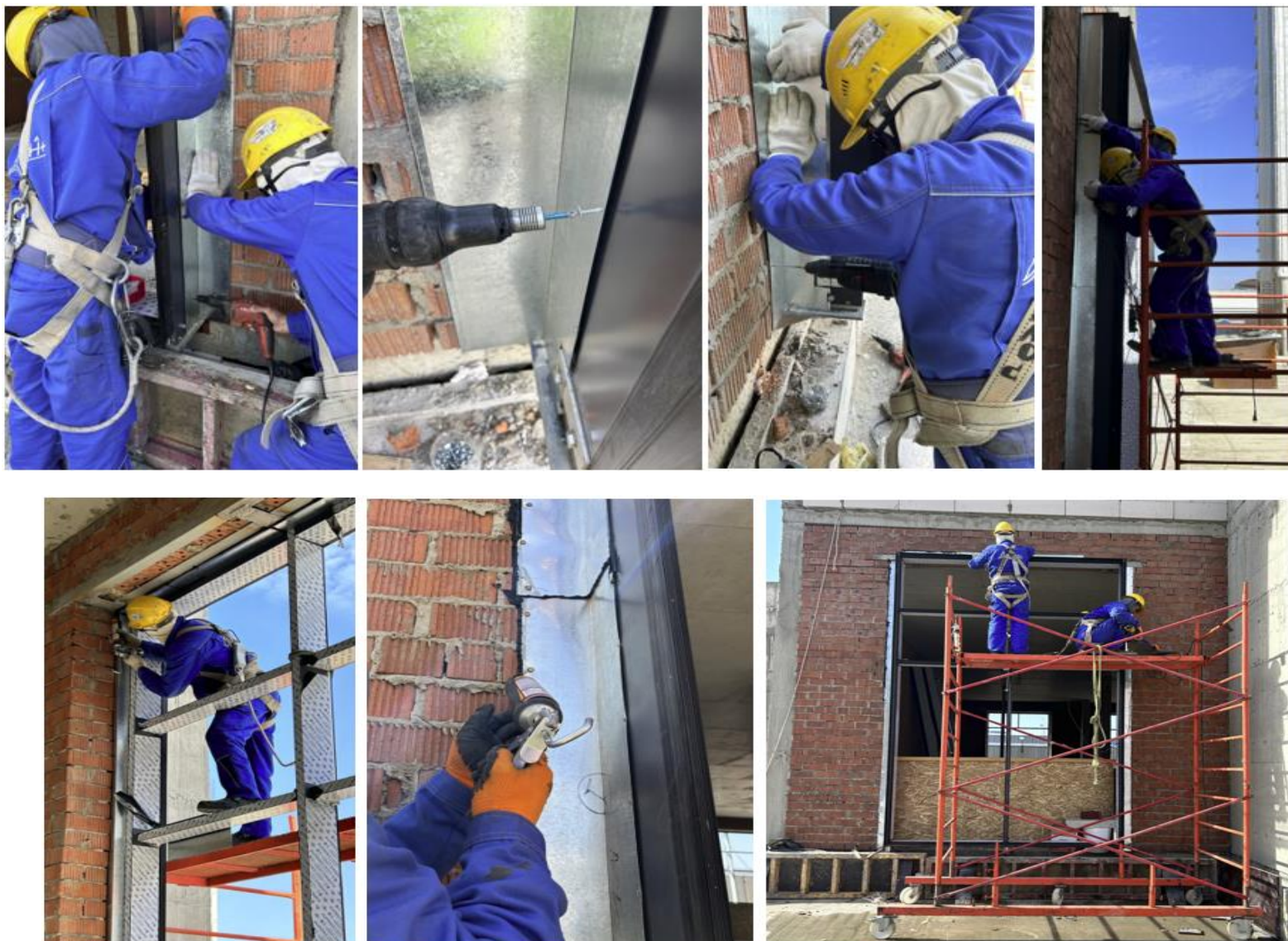
Рисунок 1.10 – Устройство противопожарной отсечки оцинкованной сталью периметра проема
