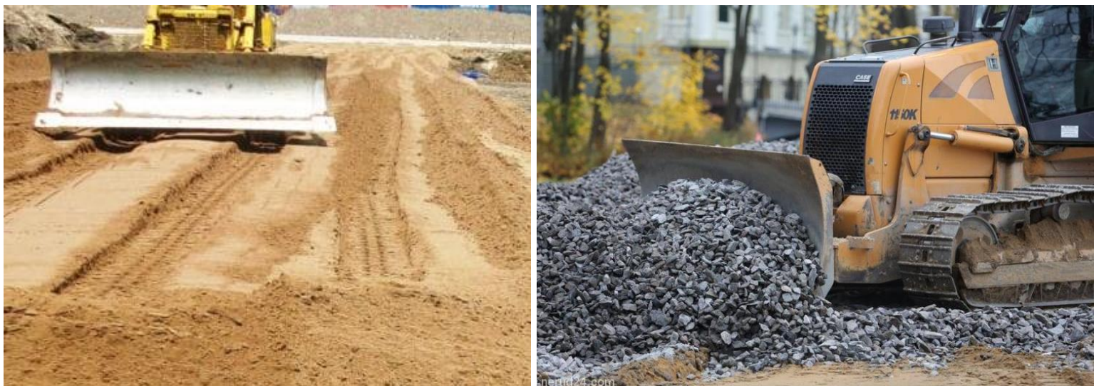
Рисунок 2 - Разравнивание материалов
