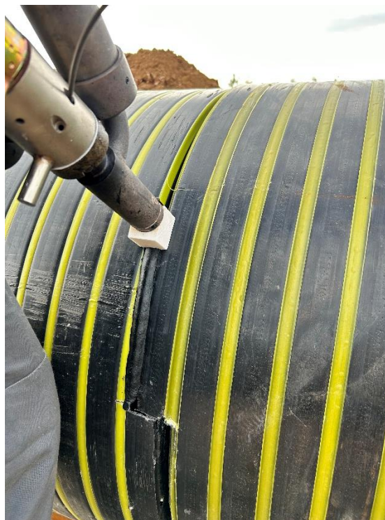
Рисунок 6 – Сварка стыков труб
