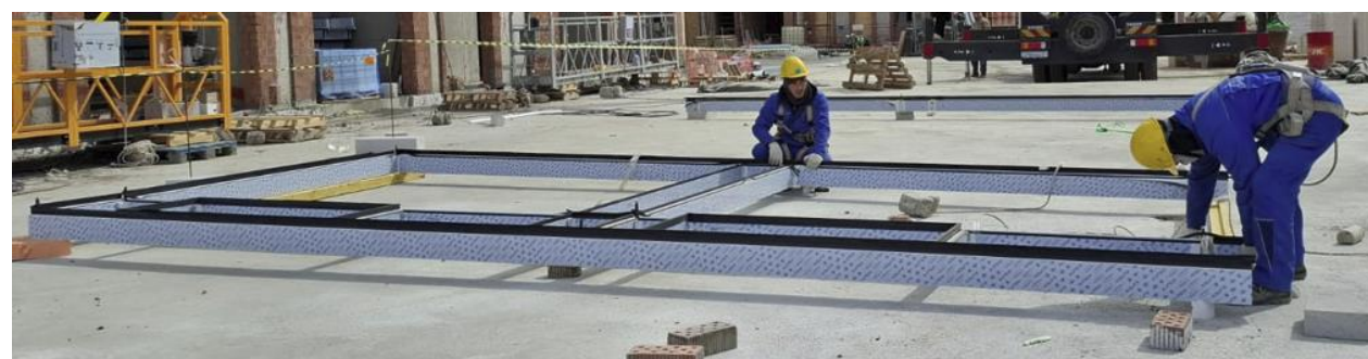
Рисунок 1.7 – Сборка рамы витражной
