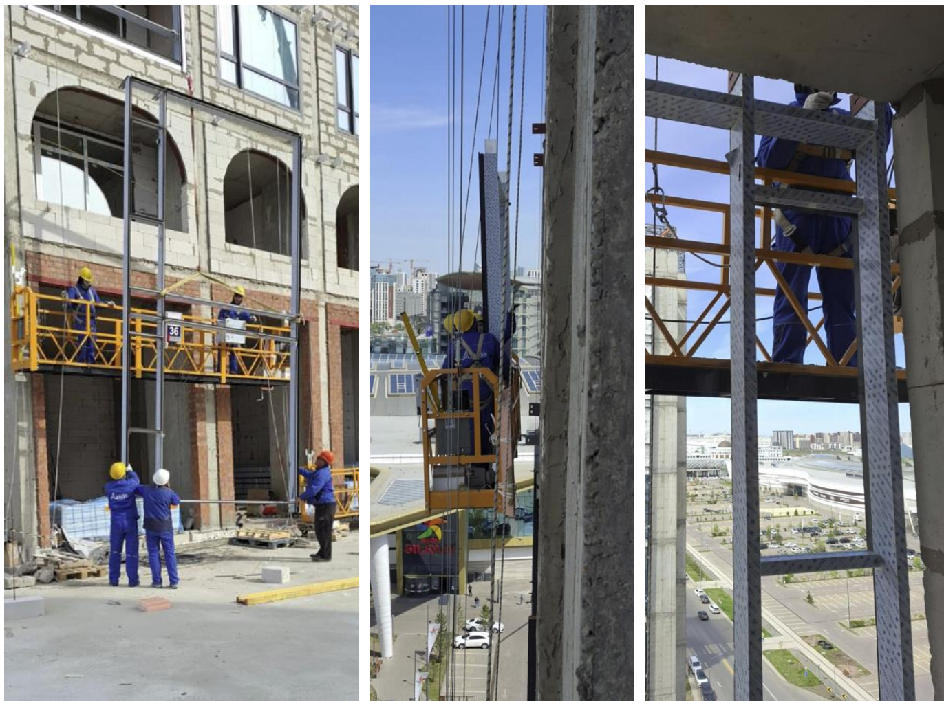
Рисунок 1.8 – Подъем и закрепление на кронштейны витражной рамы в проеме
