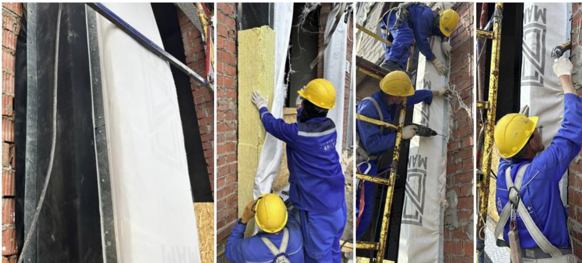
Рисунок 1.11 – Герметизация проема витражной рамы
