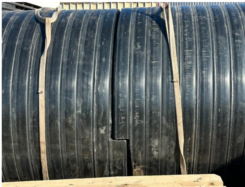
Рисунок 5 – Совмещение и центровка труб
